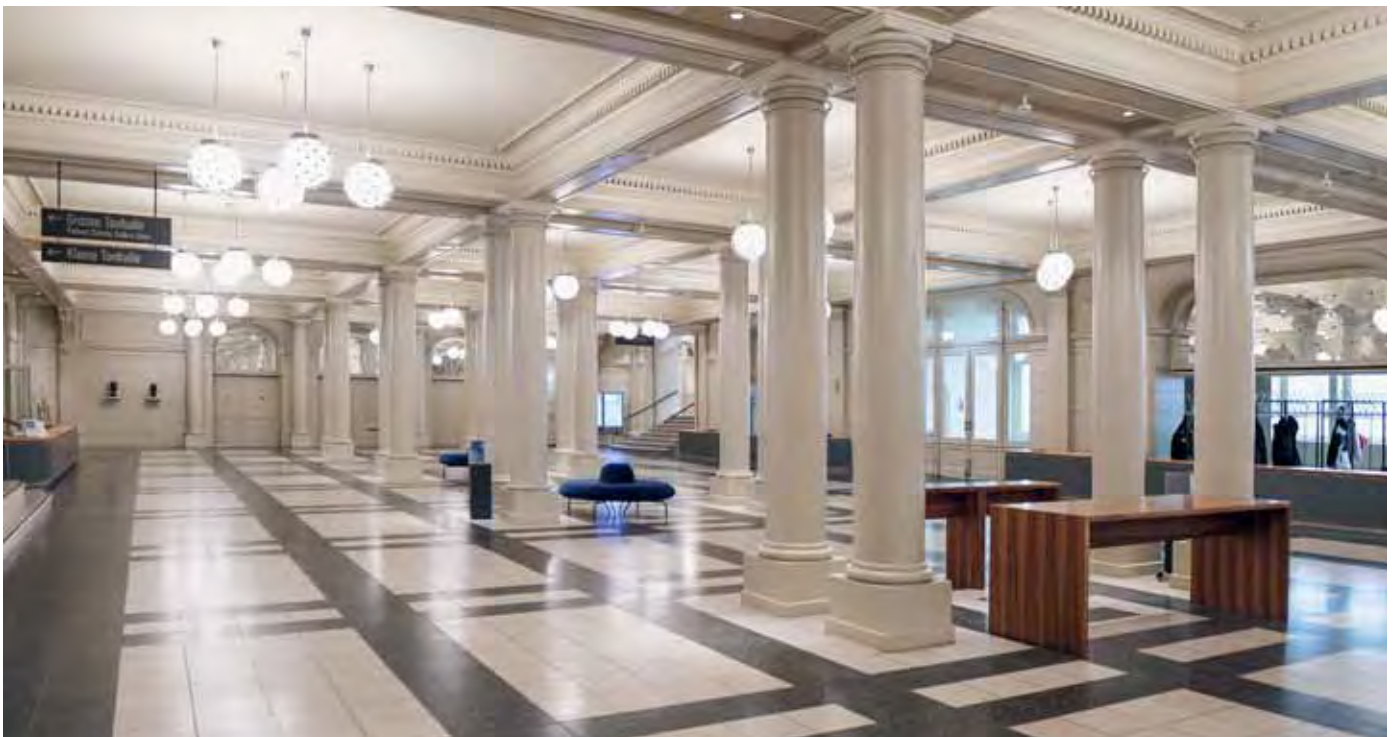
Das Tonhalle-Vestibül wurde mit wässriger Leinöl-Emulsionsfarbe beschichtet. Bilder auf dieser Doppelseite: Cornelia Sigrist
